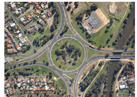
... und nach den Umbaumaßnahmen.
